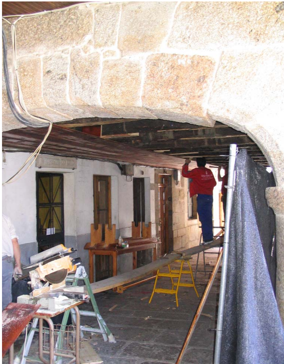
Os forxados de madeira e as paredes ou tabiques secos pódense illar facilmente.
